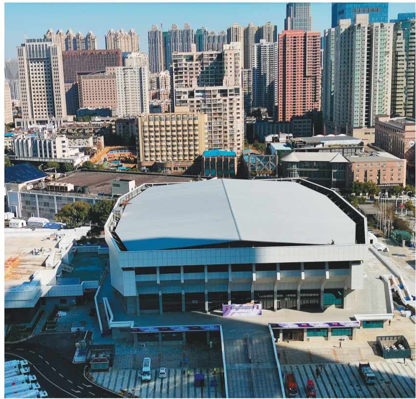
武汉洪山体育馆方舱医院是武汉第一个开舱的方舱医院。
