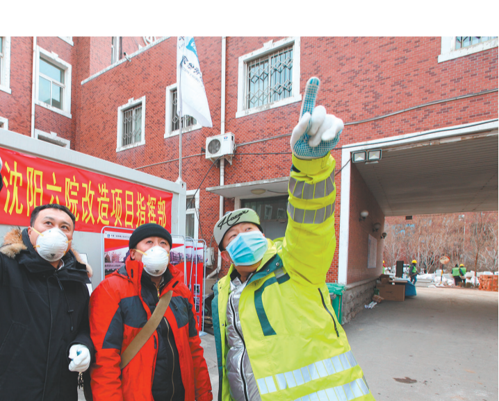
沈阳移动党员突击队在沈阳市第六人民医院新建病房5G信号覆盖工程建设现场。
