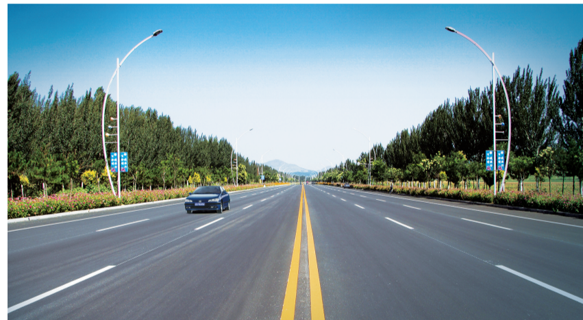
省道凌线朝凌源开发区段公路。
