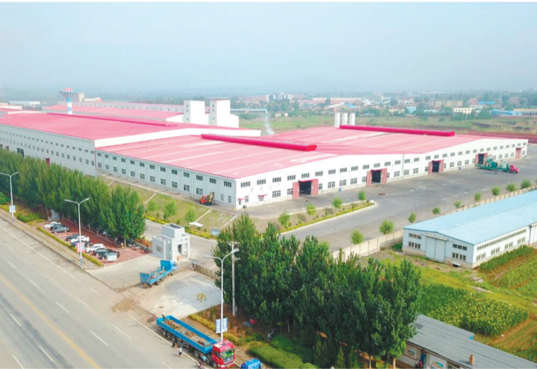
中玻朝阳新材料有限公司厂区。
