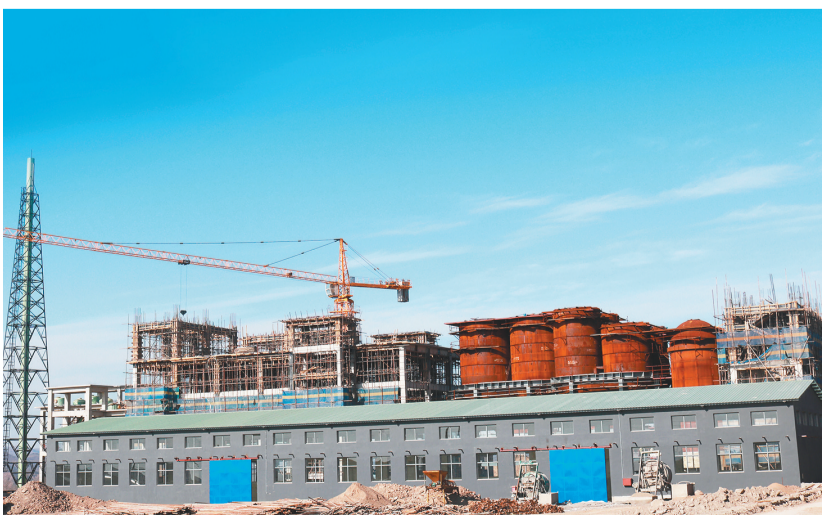
正在建设中的朝阳百盛铝业厂房。
