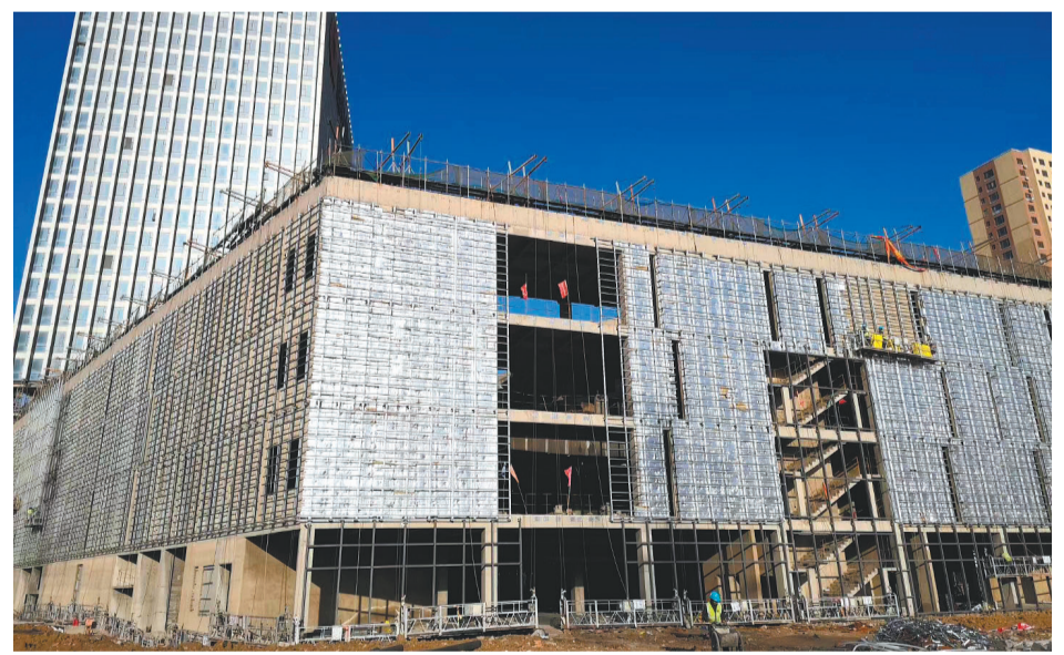
正在建设的北方国际(鞍山)健康城项目。
