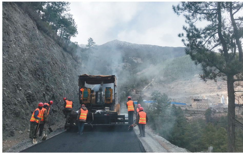
图为工人在木绒乡通乡硬化路最后一段路面铺装施工现场作业。
