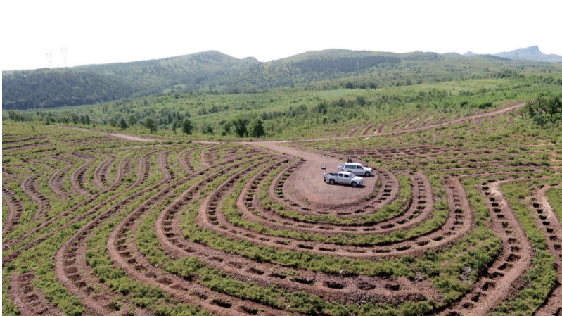
北票市三宝营偏石水土保持综合治理工程现场。
