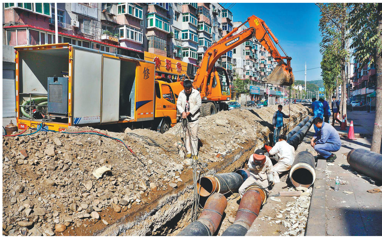
供暖管线改造工程现场。(资料片)
