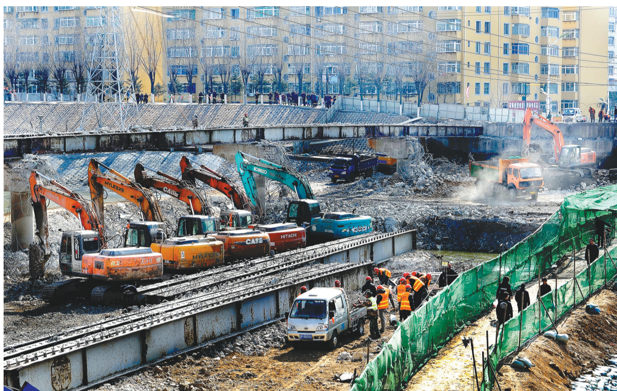
丹东市沙河桥改造施工现场。(资料图)
