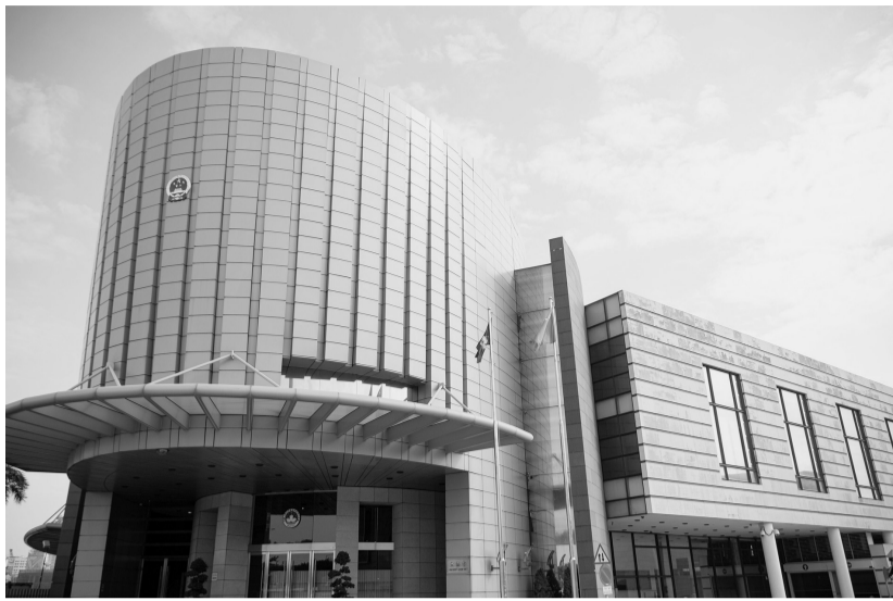
这是12月13日拍摄的澳门立法会大楼。 新华社记者 张金加 摄
