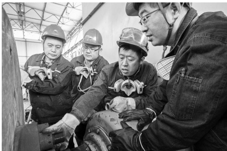
党员技术骨干带头对压缩机进行解体检修。图片由辽阳石化公司党委宣传部提供
