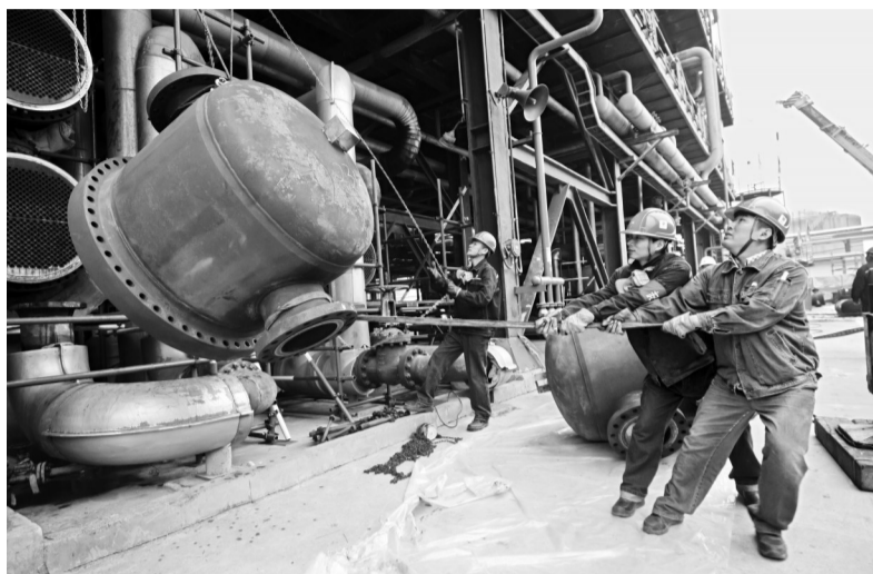
辽阳石化建修公司员工合力拆卸减压装置封头。
