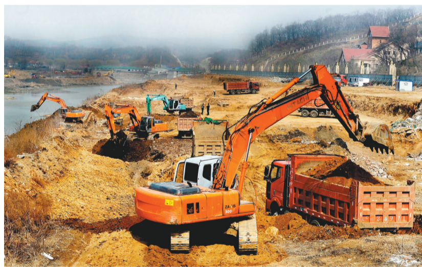
建设中的大沙河改造项目。
