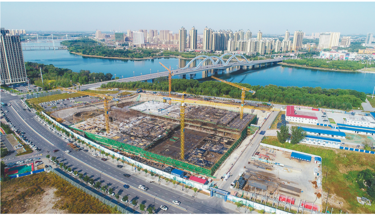
正在建设中的忠旺商务综合体项目。
