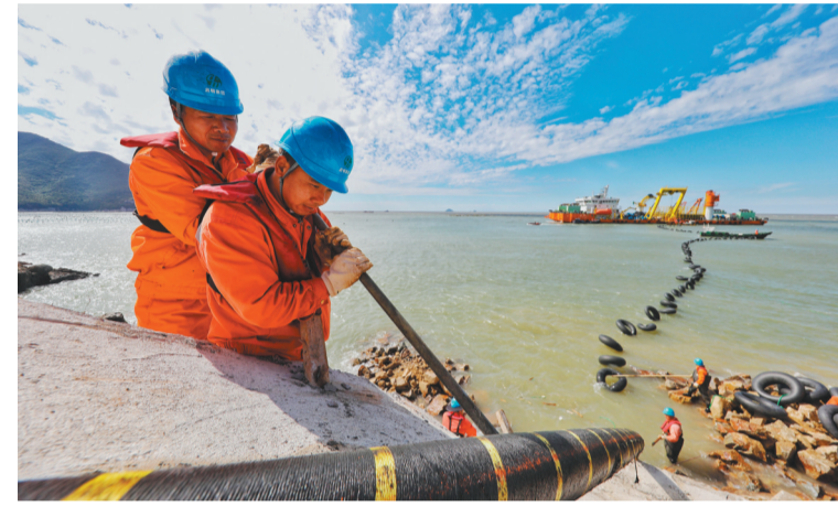
11月1日,海底电缆接入南麂岛。当日,在浙江温州南麂岛西北方向200米的海面上,5000吨级的海缆施工船“启帆9号”将海缆一段段放入水中,开始海缆首端登陆作业。浙江省唯一未跟陆地电网联网的建制镇南麂岛与陆地联网工程海底电缆敷设施工正式开始。按照计划,南麂岛将于年底前投运通电,彻底告别用柴油发电机的“孤网”时代。
