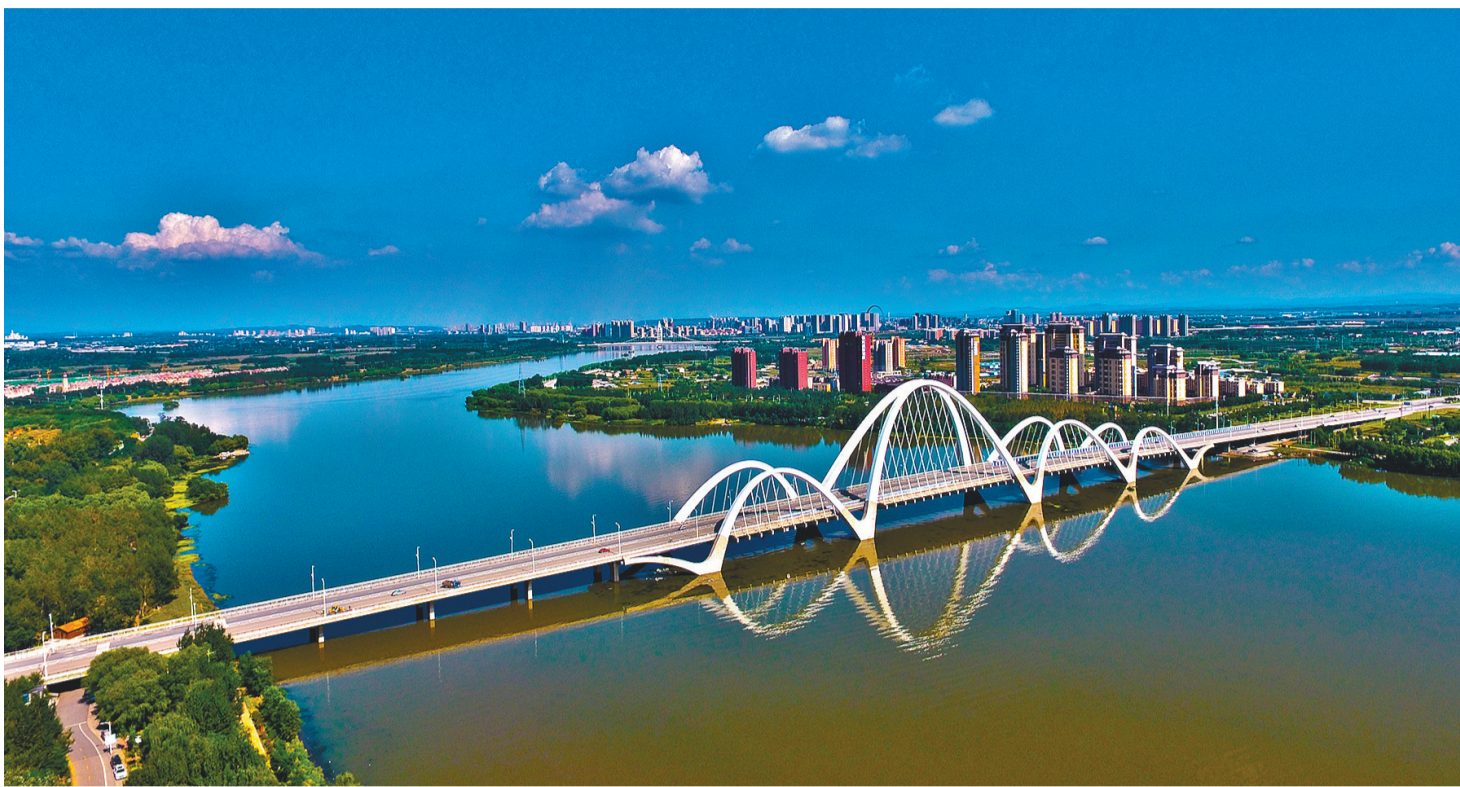
沈抚新区伯官大桥。
