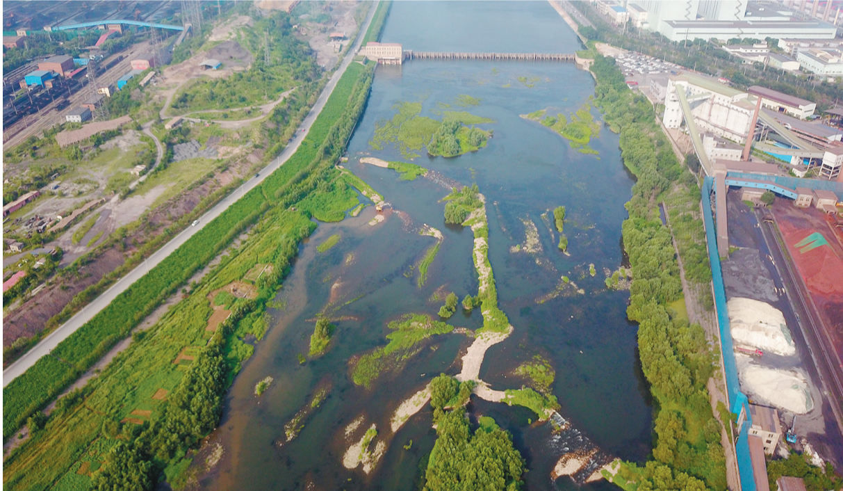
中游城区段河流生境改善与水质提升示范工程
