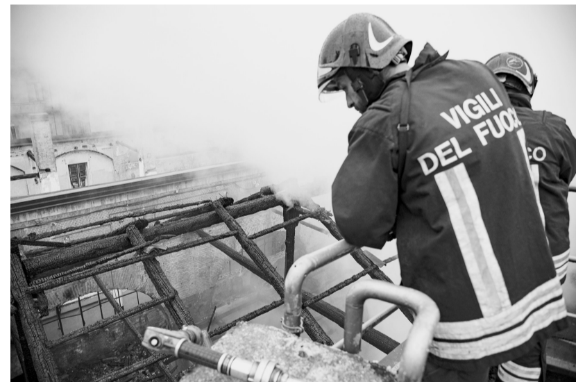
10月21日,在意大利都灵,消防员在火灾现场工作。当日,位于意大利都灵的一座古建筑起火,火灾导致其部分房顶坍塌。这座建筑约有300年历史,属于被联合国教科文组织列入世界文化遗产名录的萨沃王宫建筑群。新华社发
