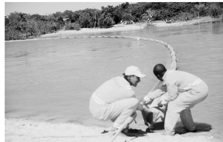
在巴西阿拉卡塔,工作人员在海滩附近设置围油栏。
