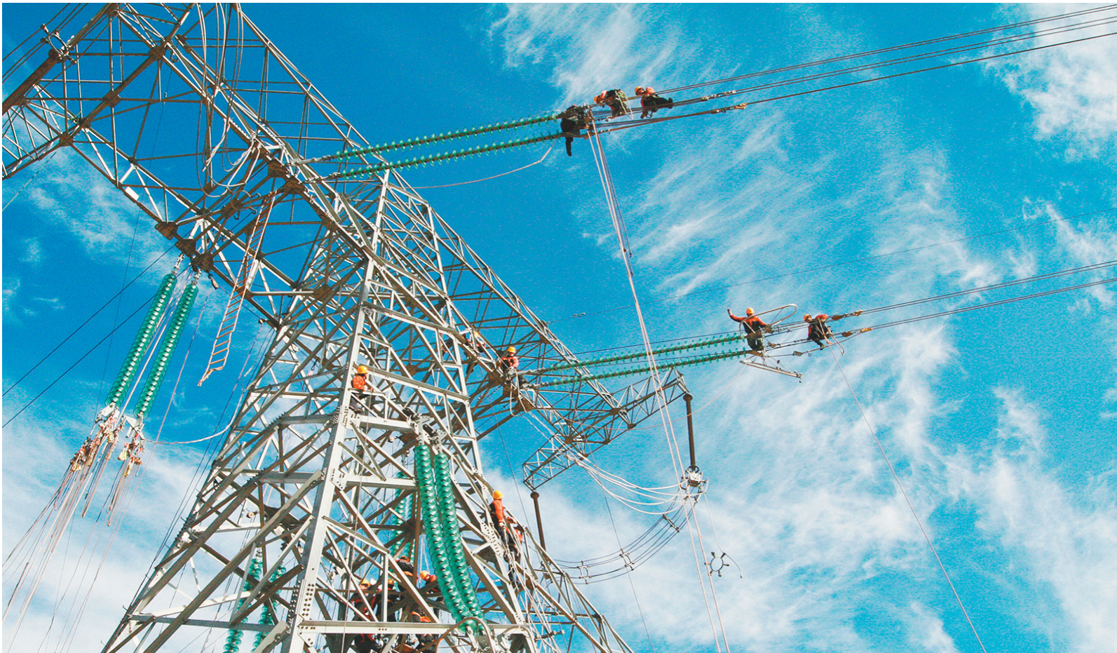
国网辽宁电力员工在500千伏宽邦线路工程安装间隔棒。
