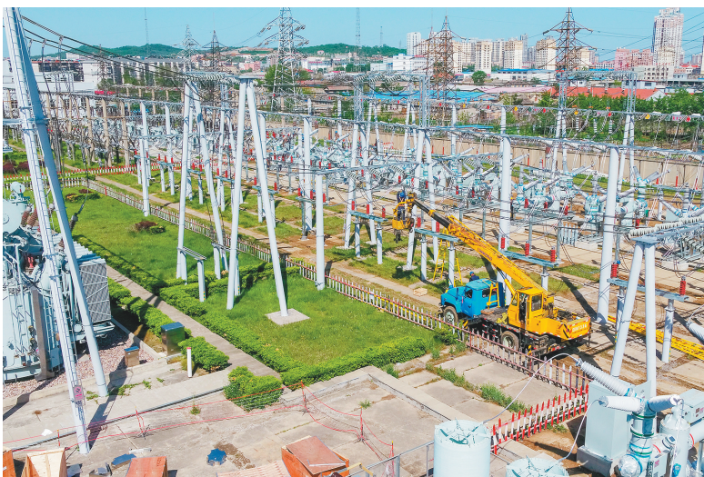
辽宁大连供电公司对吴屯220千伏变电站设备进行升级更换。
