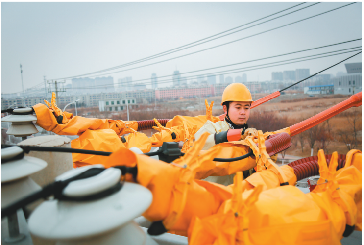
国网辽宁电力员工正在开展带电作业。
