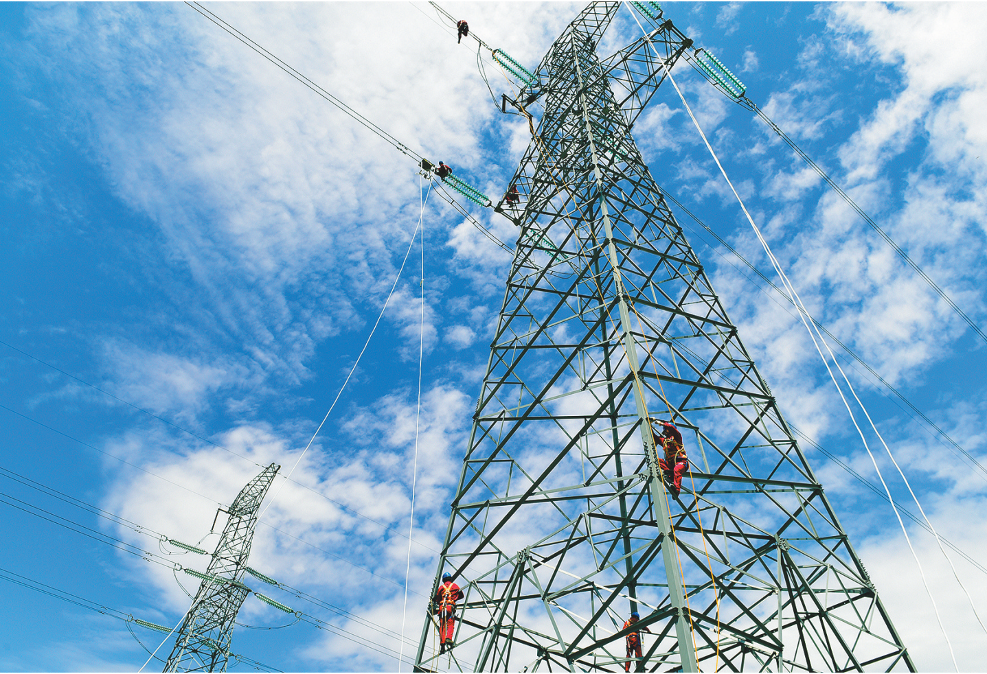
国网辽宁电力员工正在进行线路通道检查及铁塔螺栓紧固。
