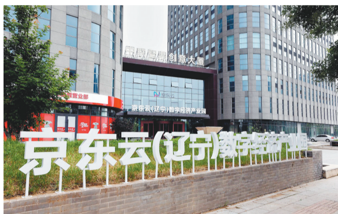
京东云(辽宁)数字经济产业园在沈抚新区落地。
