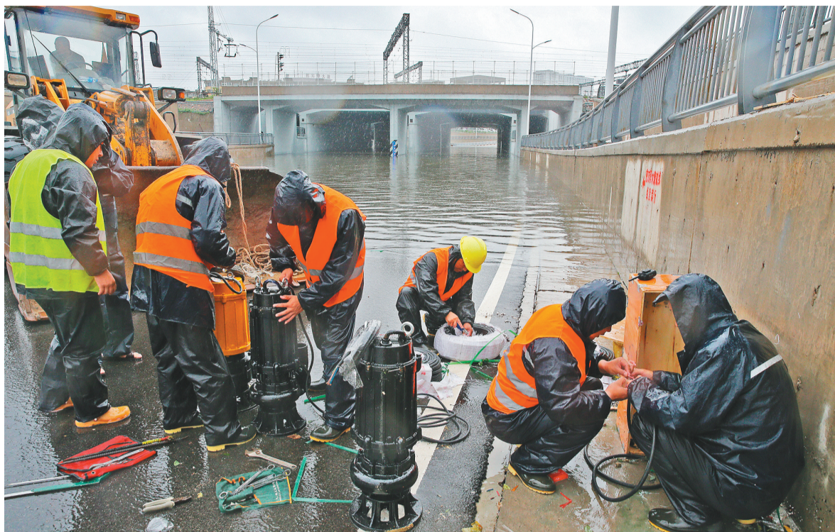
市政人员冒雨对危险地段进行排水。
