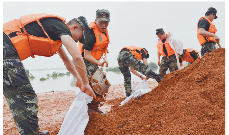
受新一轮强降雨影响,湖南、江西、福建等地发生山洪、泥石流、山体滑坡、城市内涝等灾害。武警官兵出动兵力逾千人次抢险救援,截至目前,共处置溃堤、管涌、山体滑坡等险情十余处,转移受灾群众5000余人,搬运物资1万余件。图为7月10日,武警江西总队新余支队官兵在新余市渝水区姚圩镇加固堤坝。 新华社发
