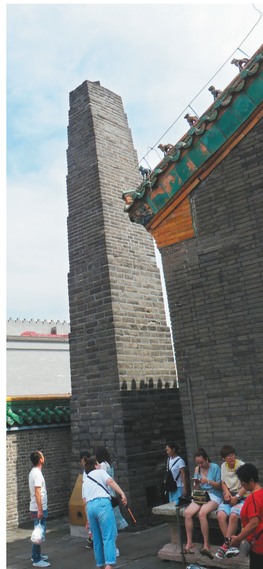
沈阳故宫内，清宁宫西山墙之侧至今仍保留着高大的砖砌跨海式烟囱。
