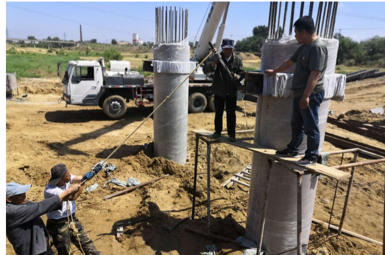
刘武(右一)在现场检查道路、桥梁施工情况。 本报记者 高华庚 摄
