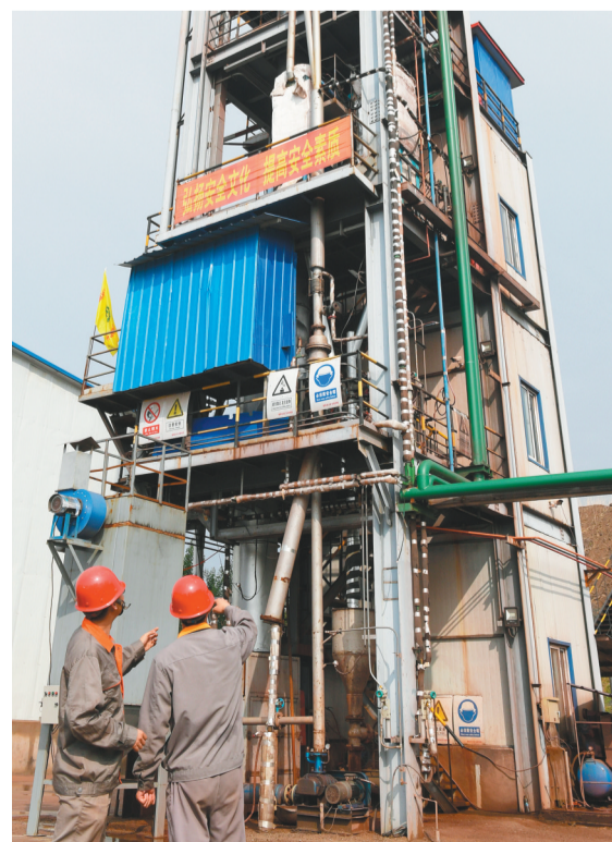
朝阳东大矿冶研究院正在进行扩大悬浮磁化焙烧中试系统炉物质磁选分离技术作业。
