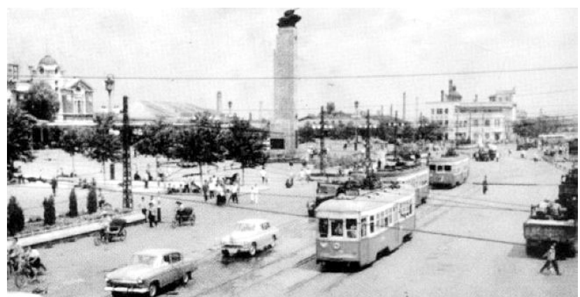
1953年11月,由铁西工人村到沈河太清宫有轨电车正式通车。(资料片)
