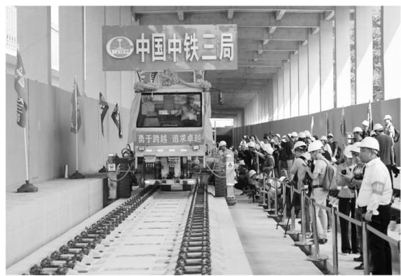
6月12日,铺轨机在京张高铁清华园隧道进行铺轨作业。当日上午,京张高铁最后一根钢轨在中铁三局WZ-500型无砟轨道铺轨机牵引下准确落在清华园隧道的轨枕上,精调之后,轨距误差在1毫米之内。铺轨历时7个月后,被誉为中国铁路发展“集大成者”、智能高铁示范工程的京张高铁实现全线轨道贯通。
