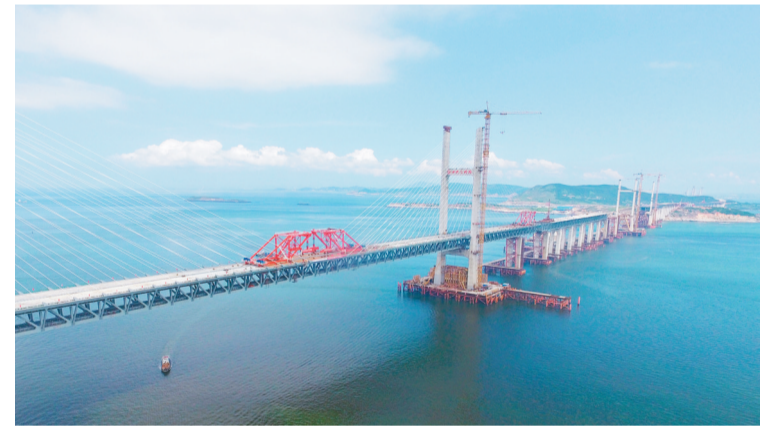
6月5日,福平铁路平潭海峡公铁两用大桥元洪航道桥主桥正式合龙。当日,福平铁路平潭海峡公铁两用大桥元洪航道桥主桥成功合龙,为下一步福平铁路全线贯通提供有力保障。元洪航道桥为双塔双索面钢桁混合梁斜拉桥,全长1188米,其中主跨达532米。 新华社发
