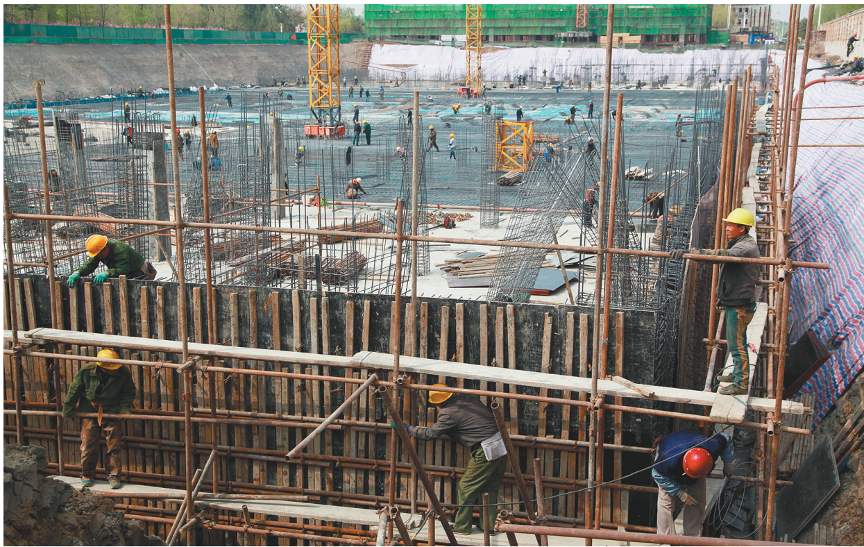
邦畿·福里项目正在紧锣密鼓建设。
