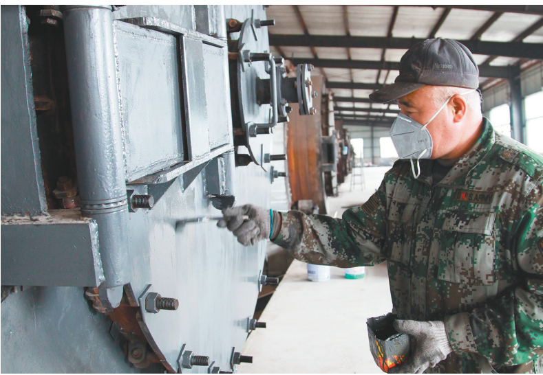
辽宁东力环保橡胶综合利用项目正在施工建设。
