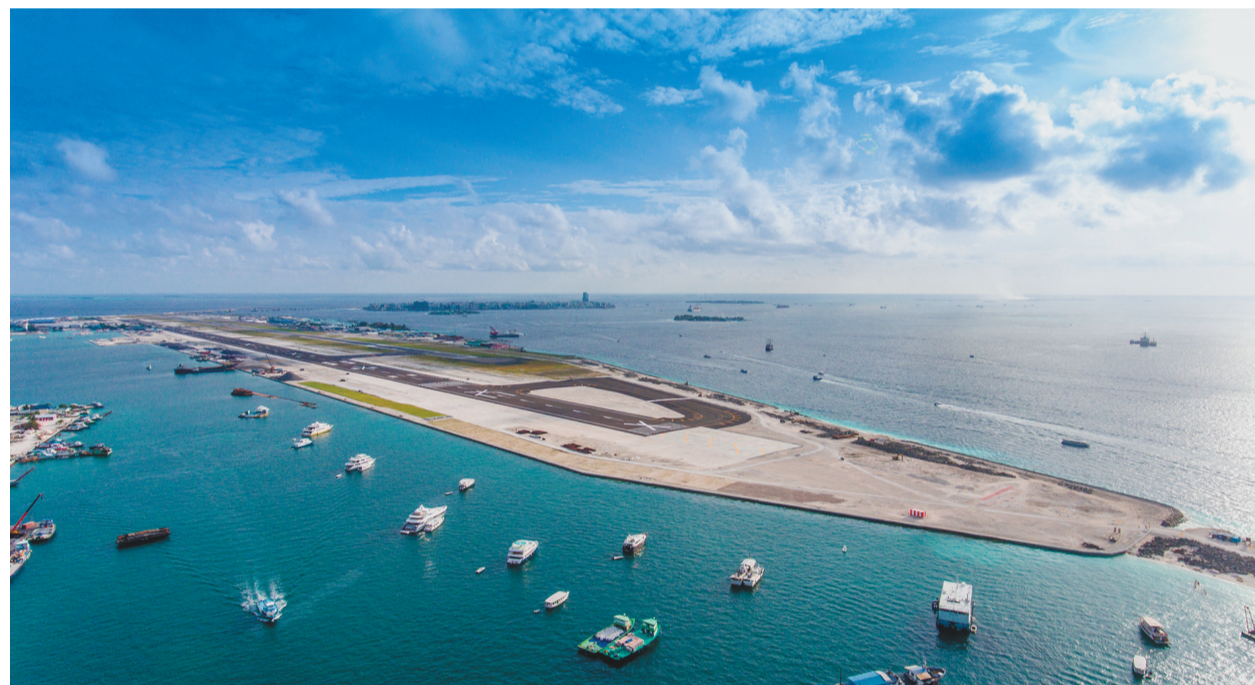
图为2018年9月14日拍摄的由中国企业承建的马尔代夫维拉纳国际机场新跑道。 新华社发
