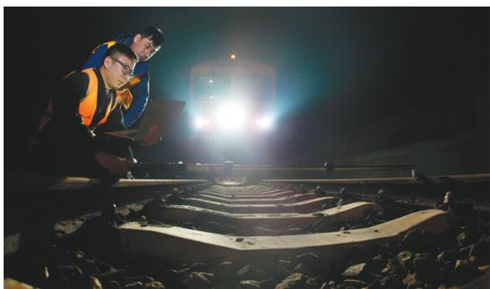
打磨作业前,技术人员勘测钢轨寻找需要打磨的点位。
