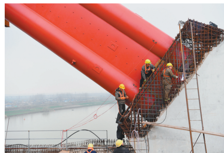
2月27日,施工人员为商合杭铁路跨淮河特大桥钢管拱提升合龙做施工准备。
