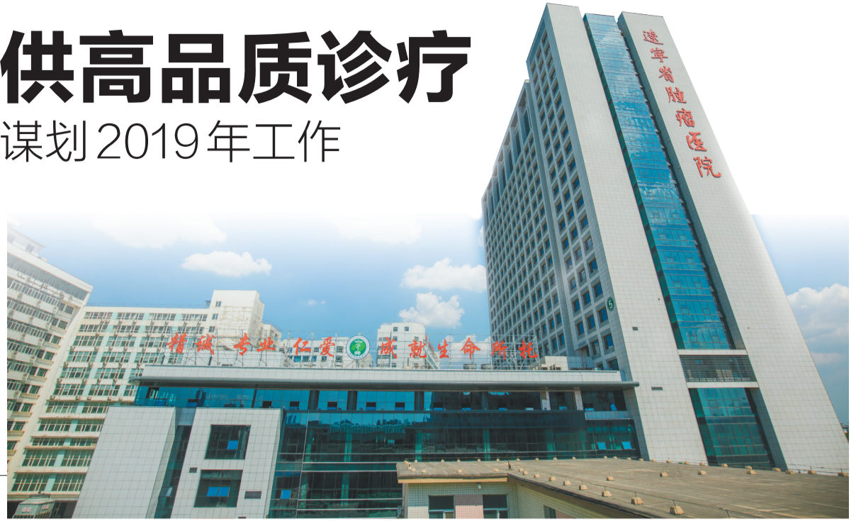
辽宁省肿瘤医院门诊病房综合楼。
