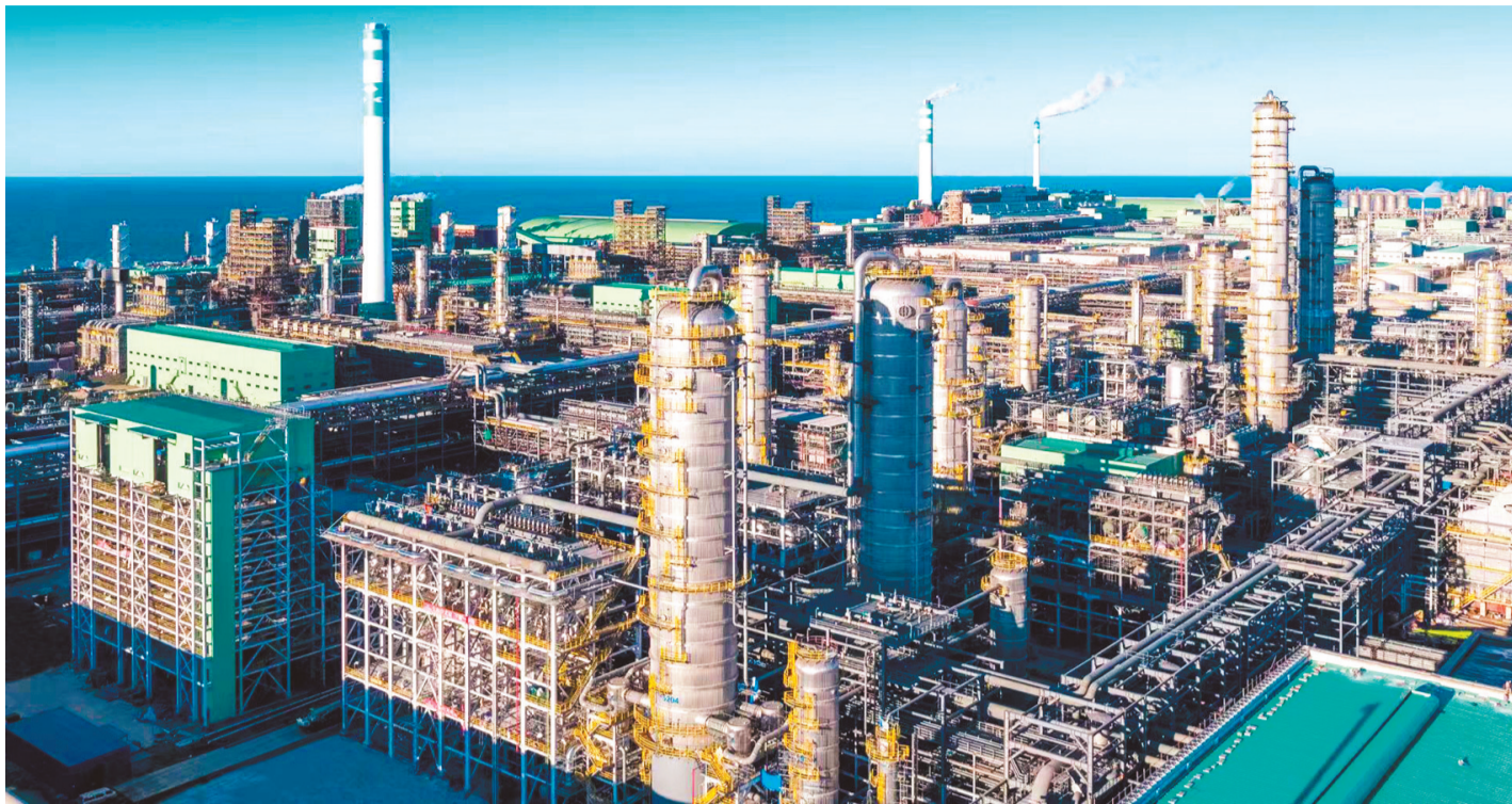
恒力2000万吨/年炼化一体化项目建设现场。
