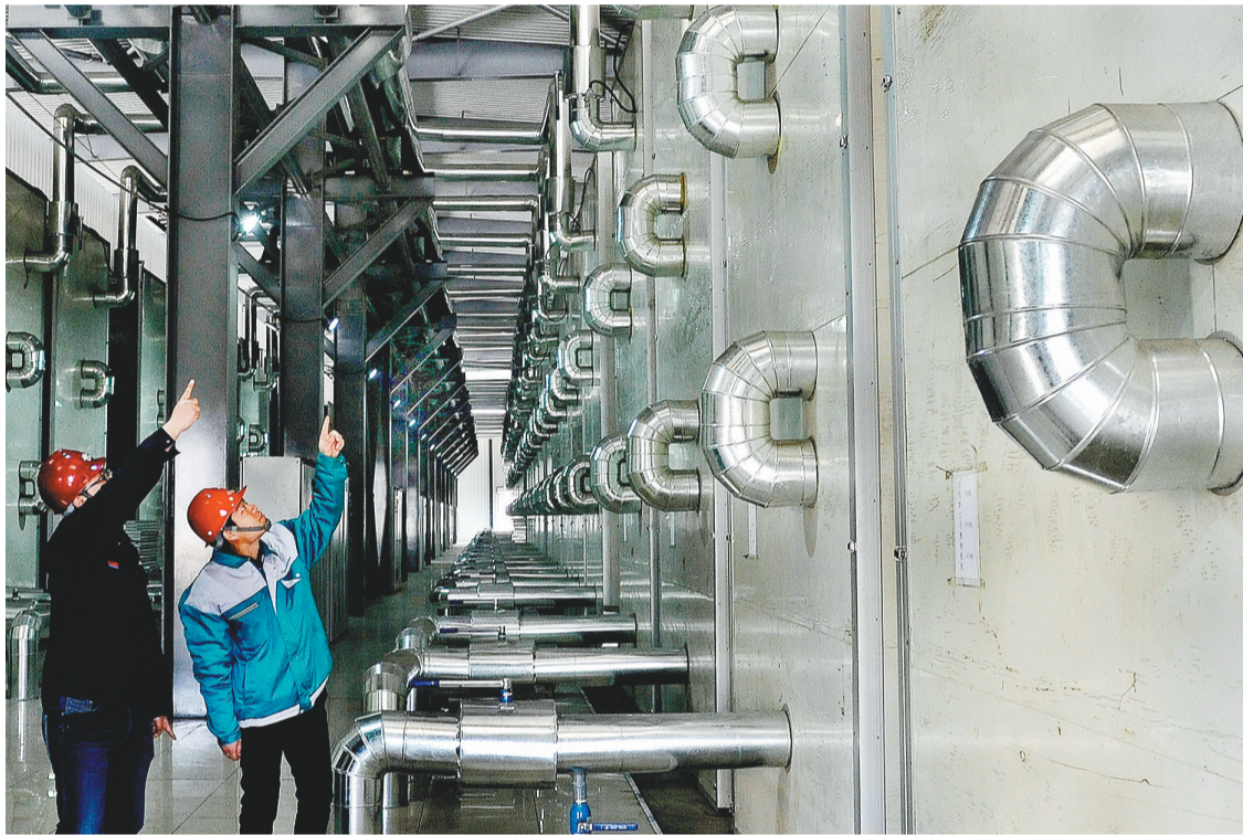
丹东市把大讨论落在民生问题上，金山热电厂项目保障丹东市冬季集中供热。 刘海东 摄
