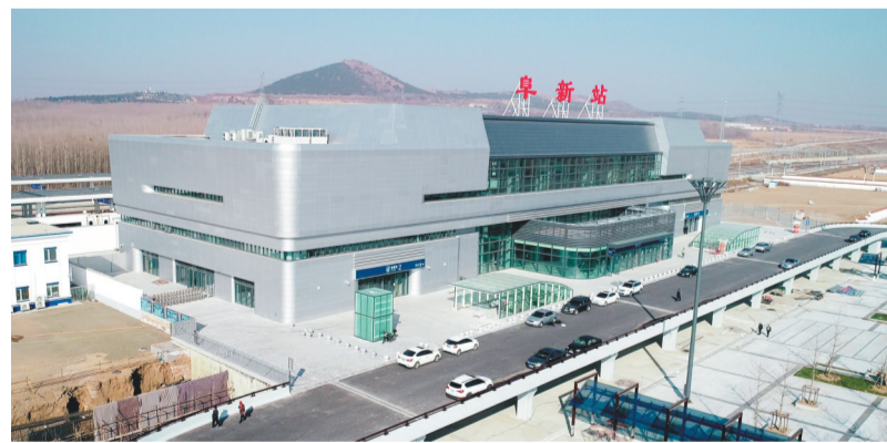
即将投入运营的京沈客专阜新站。
