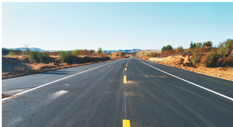
由建平县交通局修建的牛京线(高铁连接线)。
