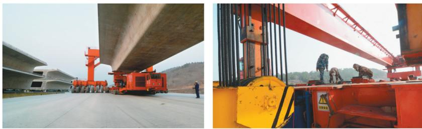
11月5日,朝凌客专TJ-2标段唐家岭特大桥建设现场一片忙碌,随着架梁作业人员操纵着架梁机将一片32米长的箱梁稳稳地落在唐家岭特大桥墩上,中铁上海工程局集团成功架设了朝凌客专TJ-2标段的首孔箱梁,标志着该标段箱梁架梁工作正式开始,工程建设取得重大进展,为完成年度产值目标奠定了坚实基础。
